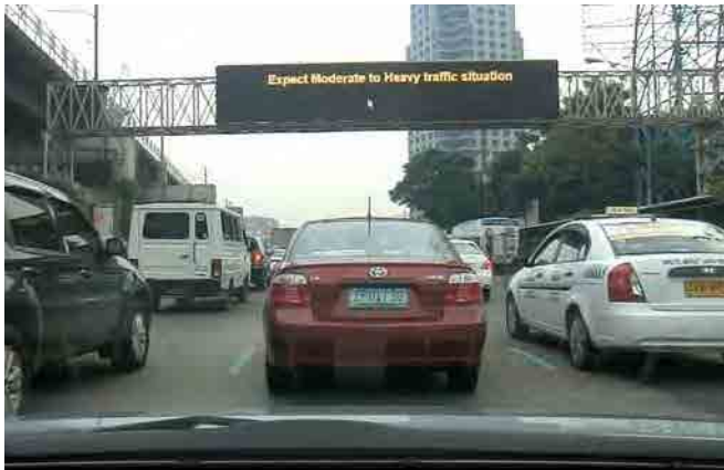
図 6.3-15 可変情報板の設置・運用状況
