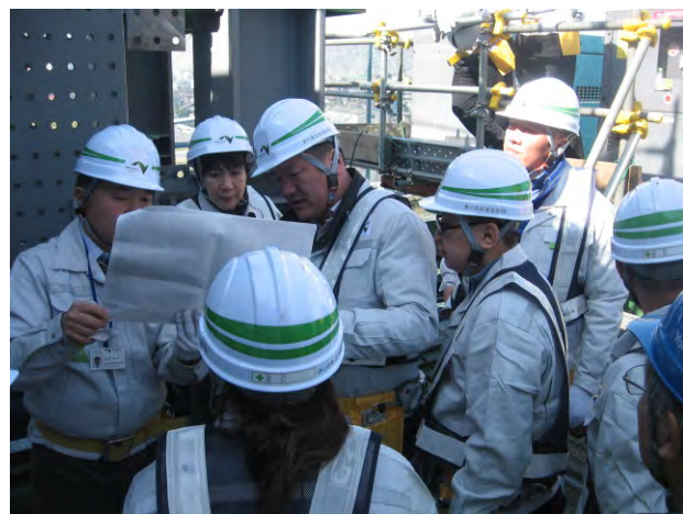
③3月12日 新葛飾橋の施工現場で説明を受ける研修員
