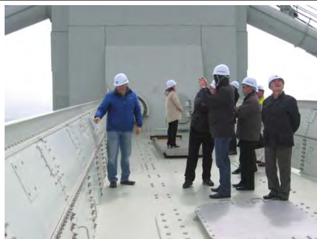
3月14日 明石海峡大橋の主塔から視察を行う研修員
