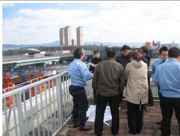
3月14日 守口JCTにて施工現場の説明を受ける研修員
