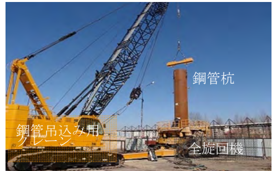
図 7.5.1 回転圧入鋼管杭施工状況
