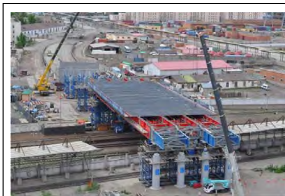
図 9.2.4 送り出し架設の様子
