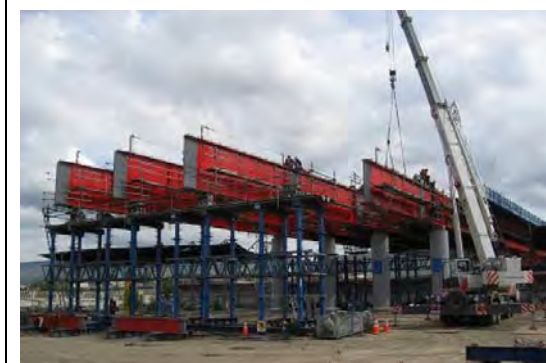
図 9.2.5 クレーン・ベント架設の様子
