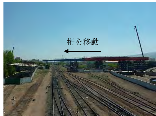
図 7.5.8 鉄道上の架設方法(太陽橋)
