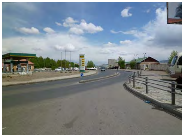
写真-6 ナルニー通りとの交差点(その2) (ウランバートル駅方面)
