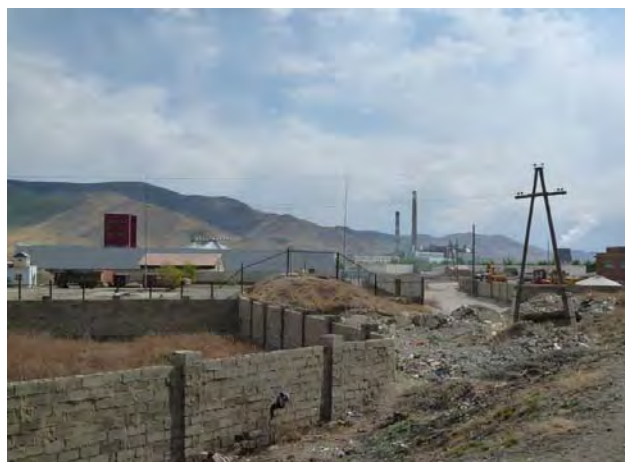
写真-2 アジルチン跨線橋予定地(その2)
