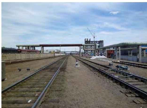
写真-3 跨線橋予定地からウランバートル駅側
