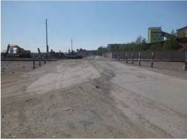
写真-13 跨線橋西側着地点付近
