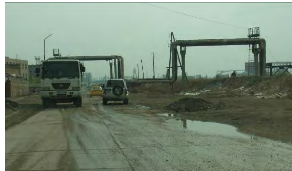
図 6.4.2 STA. 0+440 付近の給湯管
