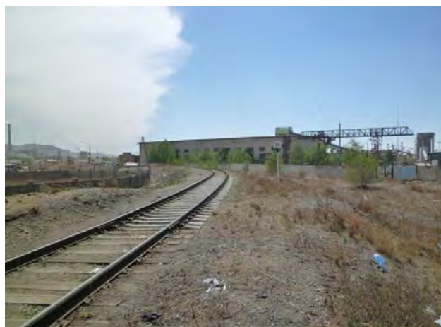
写真-4 第3火力発電所方面への支線
