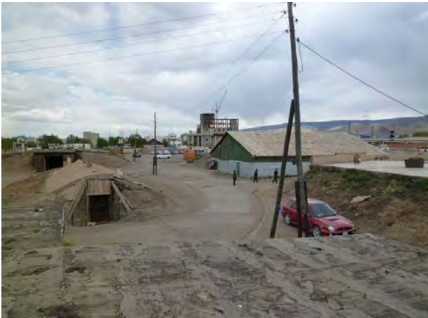
写真-9 鉄道北側鉄道会社施設内 (ヤード候補地)
