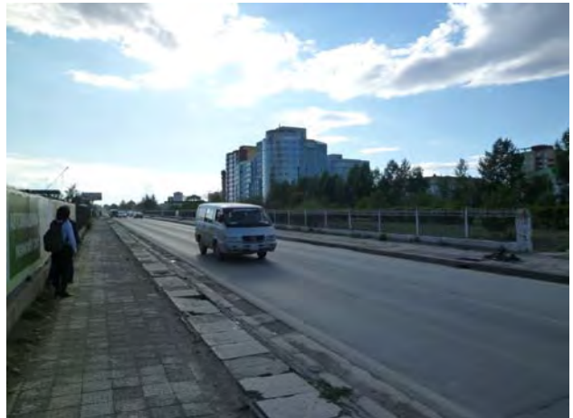
写真-14 跨線橋東側着地点付近
