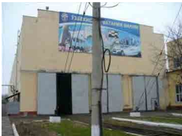
電気機関車の検修庫全景
