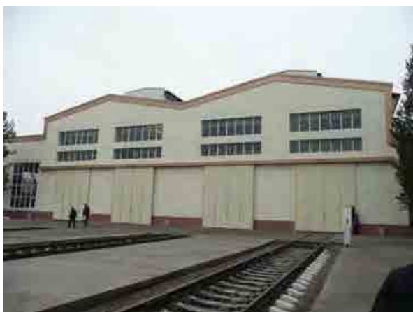
Afrosiyob 号の検修庫全景
