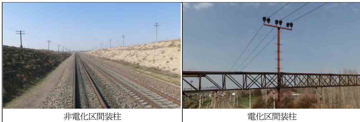
【写真 2.4-3】非電化区間装柱と電化区間装柱
