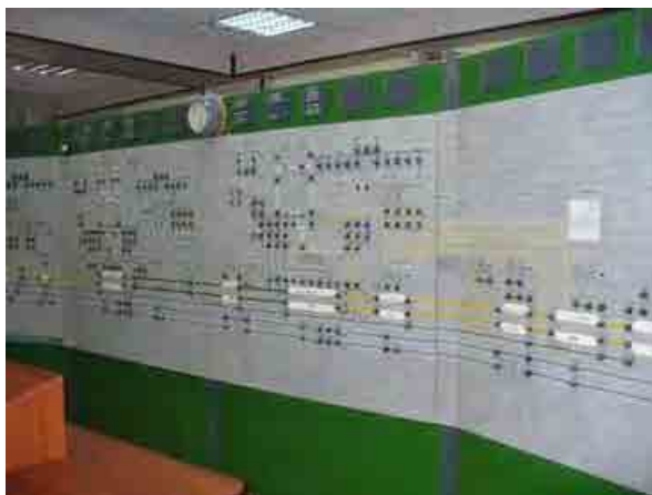
Tashkent~Djizak 間：系統表示盤
