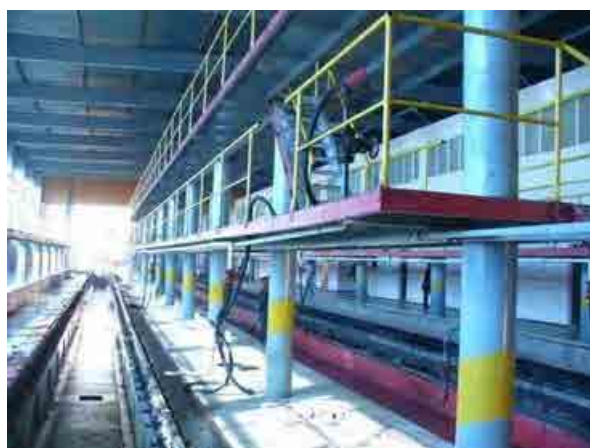
新検修庫内部
