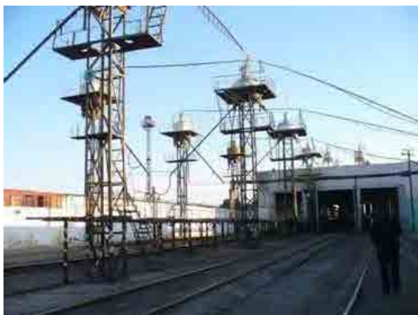
砂補給設備
