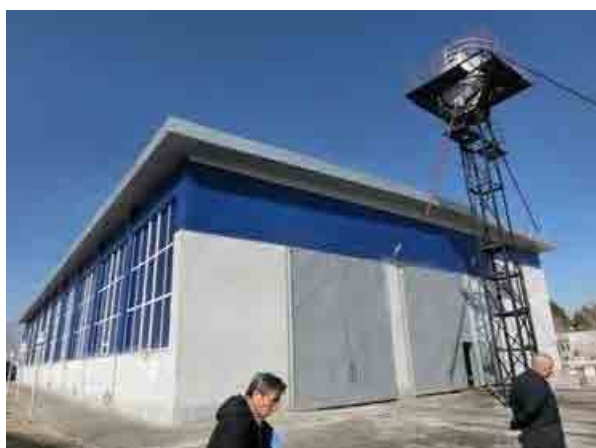
新検修庫全景
