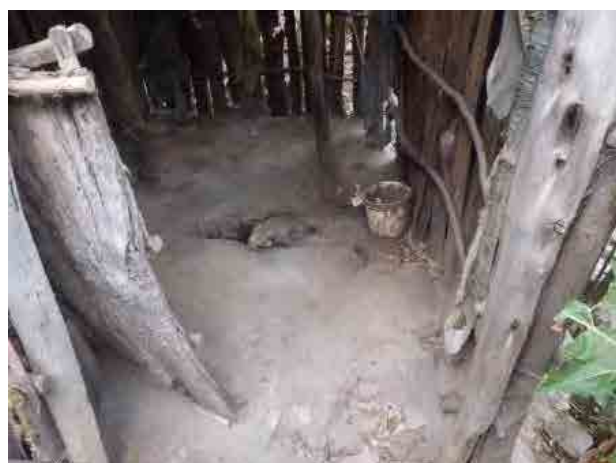
左トイレ。素堀ピットラトリンで、蓋の役割をする石が置かれている。清掃は可能。
