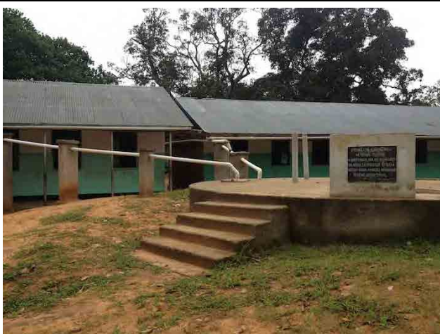
Lindi 州で見かけた雨水利用施設。貯水槽を低く半地下の構造で設置している。
