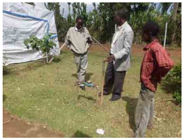
Shebadino Woreda Shiro Kebele の保健ポスト内の水栓。上小学校と同じ管路系給水施設の一部。水料金の未納が続いているため現在給水停止中。
