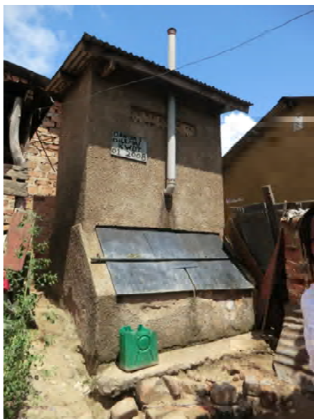
DANIDAとNGOによって建設された家庭用エコサントイレ。2008年に建設されてからずっと使用されている。堆肥化された排泄物は近隣農家が2回取りに来た。(2012/12/13 Mukono 県 Katosi 村)
