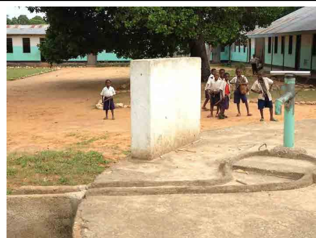
半地下に貯水された雨水をハンドポンプでくみ上げることになっているが、稼働状況は良くない。
