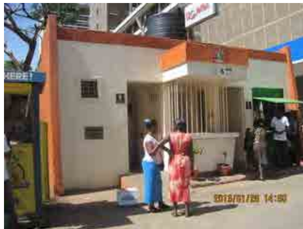
Ecotact による運営のナイロビ市内公共トイレ。裏は靴磨きのビジネスを行なっている。 (2013/1/26 Nairobi)
