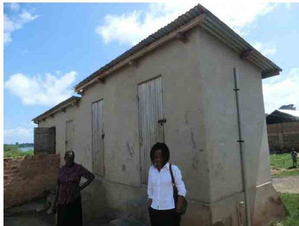
2011年にNGOが建設した学校用エコサントイレ。建設費用は約5.7百万UGX(2013/12/13 Mukono 県 Katosi 村)
