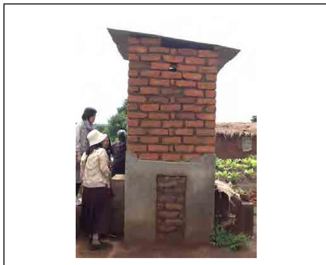
Nkotankota 村落の ECOSAN トイレ (NICCO)
