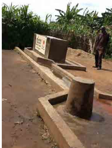
上トイレと同時に設置されている給水施設。奥には洗濯場があり、排水柵も併設されている。
