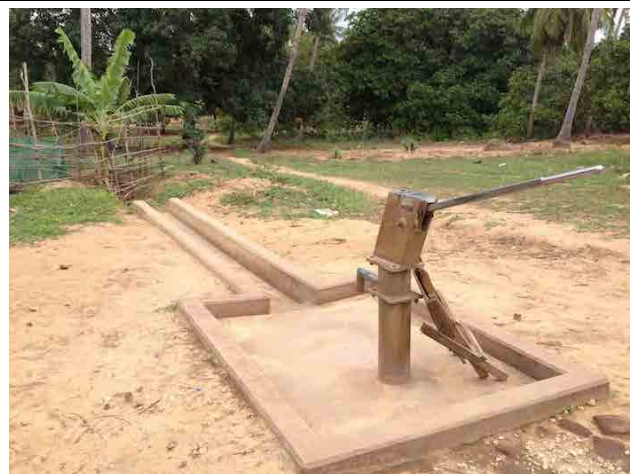
左診療所の敷地内に設置された給水施設
