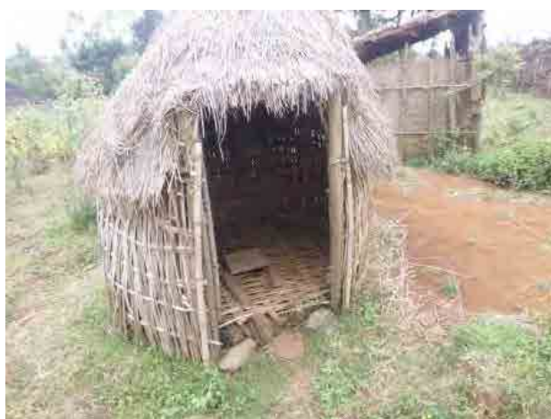
Hulla Woreda の一世帯。左給水施設の近隣にある。衛生普及員の活動が活発化しており、この世帯では基礎的なトイレの建設を進めている。手前世帯用、奥は訪問者用で、清掃可能。
