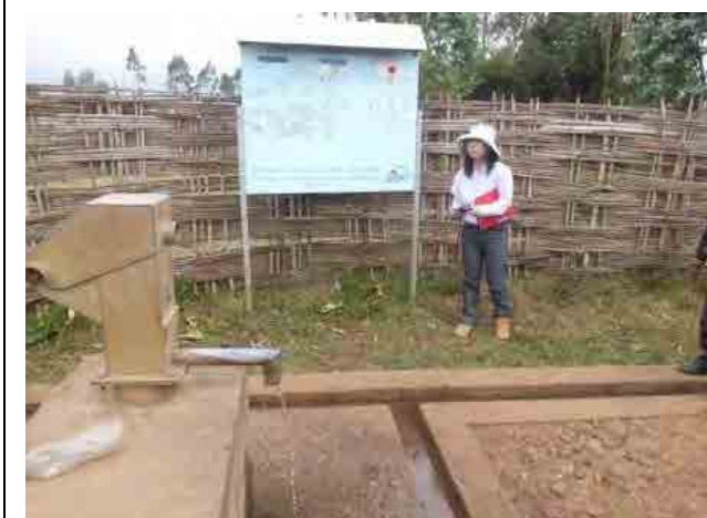
Hulla Woreda WASCAP 対象のハンドポンプ付き給水施設。故障は無く、給水は問題なくできるが、利用者数はあまり多くない。
