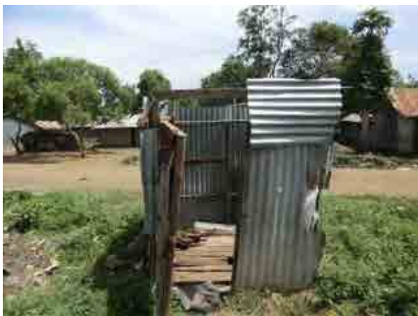
スラムにおけるアパートの共同トイレ。家主が現地に住んでいないため適切な維持管理がされない。 (2013/1/25 Homa Bay 市)
