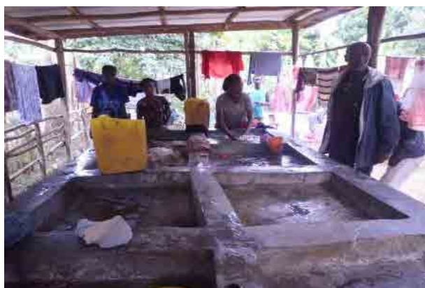
Medregenet 水組合が設置したサニ・マート。トイレ、シャワー室、洗濯場など衛生施設を共同で利用できるよう、また、展示の意味合いも兼ねて設置している。
