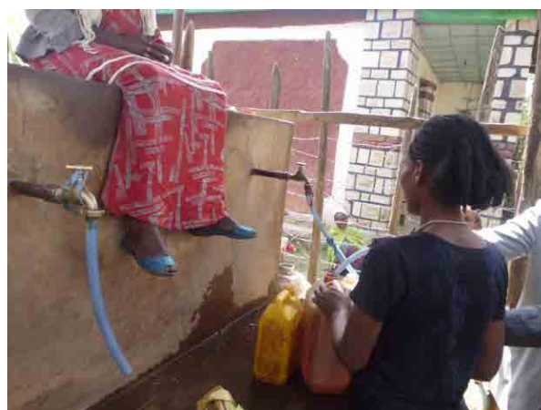
左と同じ公共水栓で取水する住民。水運搬のための JERRI-CAN が汚れていないか？など水栓管理人が声をかける。
