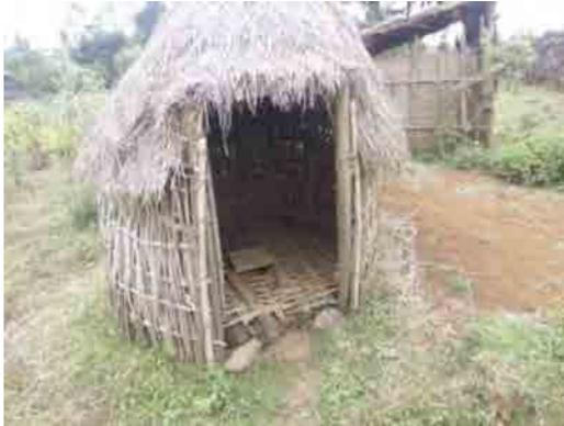
世帯内に設置された基礎的な衛生施設。扉を開けた状態。家族が利用する。木材を組んだ上に清掃をしやすいように竹を編んで作ったプラットフォームがあり、ピットの穴には蓋が常備されている。奥に見えるのは客人が利用するトイレ。内部は同じ作りであるが室内が広い。直近に水のはいった簡易な手洗器=Tippy tap が設置されていた。
