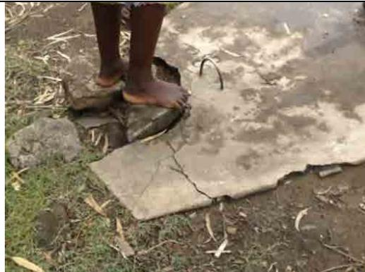
足場たたきのコンクリートが崩壊している。
