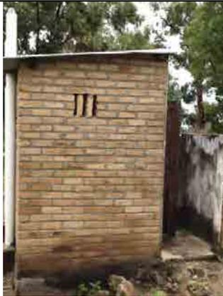
トイレは4棟ある。基礎地盤が洗掘されている。
