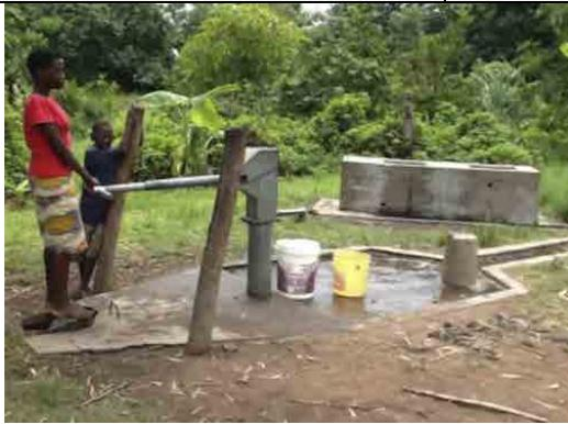
学校に隣接するハンドポンプ式給水施設。洗濯場（写真奥）をすぐ横に建てるのは「マ」国で一般的になっている。
