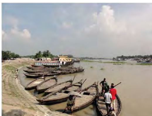
写真 大規模侵食後の復旧護岸
