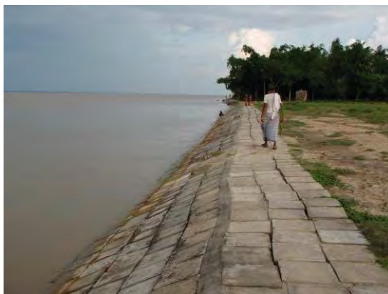
写真 既設護岸
