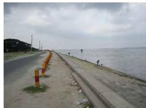
写真-8 Jamuna 川右岸の緩傾斜護岸整備状況
