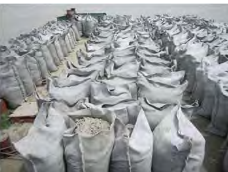
写真-7 大型土嚢の仮置場
