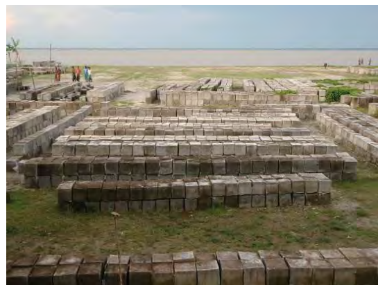
写真 高水敷の CC-block 制作ヤード
