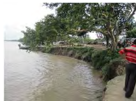
写真-4 Padma 川右岸の河岸侵食状況
