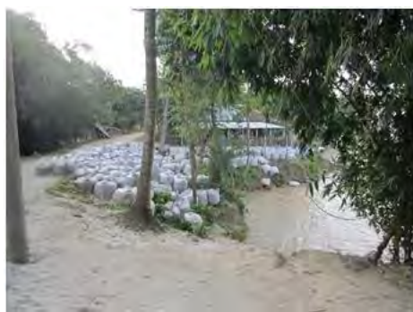
写真-3 Padma 川右岸の河岸侵食状況
