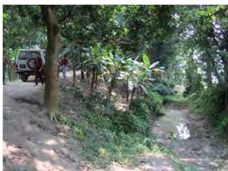
写真-13 Shitlakkya 川左岸の現況土堤
