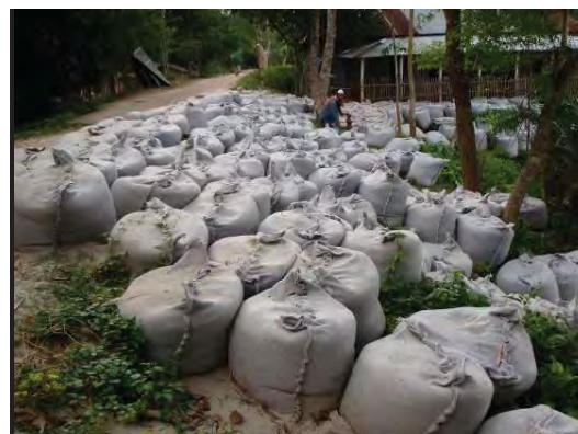
写真 応急処置用の Geobag
