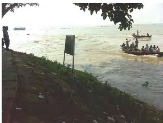
写真 水衝部の護岸状況
