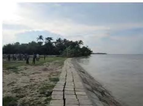
写真-2 Padma 川右岸の緩傾斜護岸整備状況
