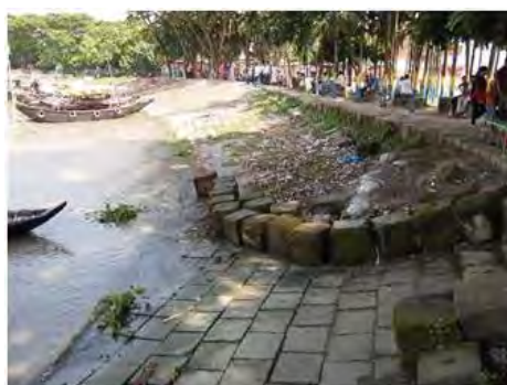
写真-14 Chandpur 緩傾斜護岸の整備状況
