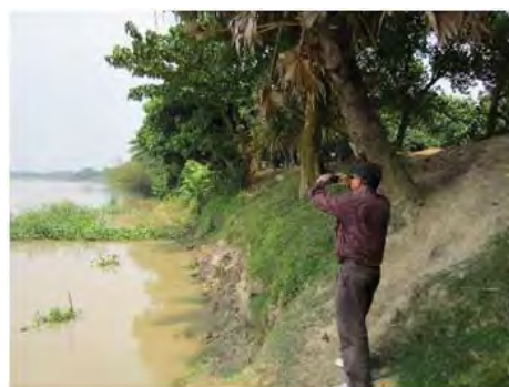
写真-12 Shitlakkya 川左岸の河岸侵食状況（2）
