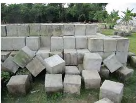
写真-5 護岸ブロックの仮置場
