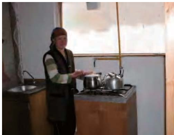
バイオガスを用いたガスコンロ
