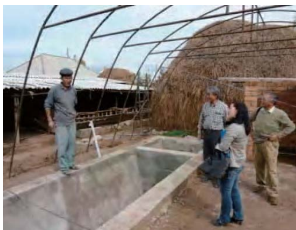
現在建造中のバイオガス装置（カナル型）
