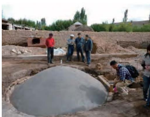
現在建造中のバイオガス装置（ドーム型）
