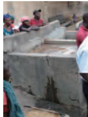
2槽式のタンク
