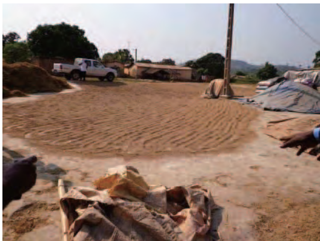
【写真2】 コンクリートが打たれた籾乾燥場
