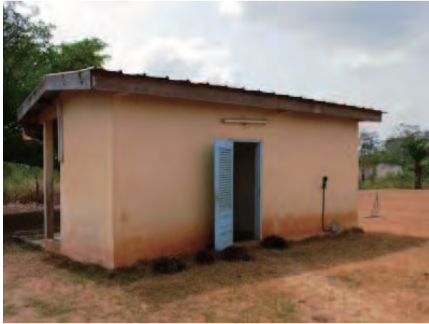
写真1 改装予定の所長室
