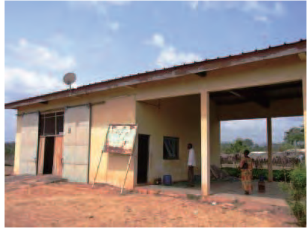
写真2 同改装予定の研修棟
