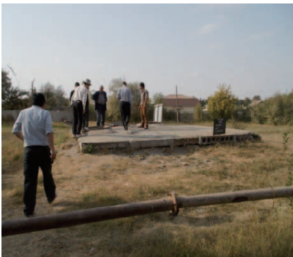
④No.5の井戸は、地下掘込み式井戸で、井戸深度が200mである。ポンプは2台設置可能であるが、1台のみ設置している。
