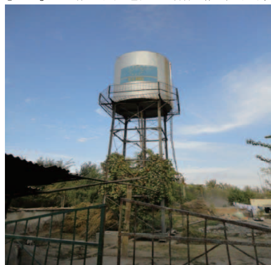
④Selga村の既存高架タンク
