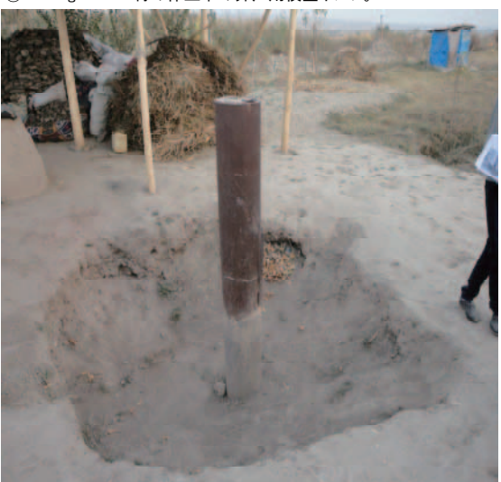
⑤Selga村の休止中の井戸。揚水に伴う砂吸出しによる地盤沈下が見られる。
