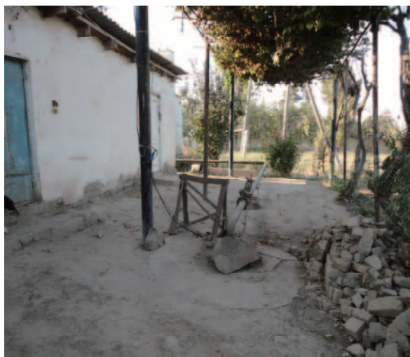
③Tugul村の学校裏の井戸は2008年洗浄を行い、最近まで稼働していた。
