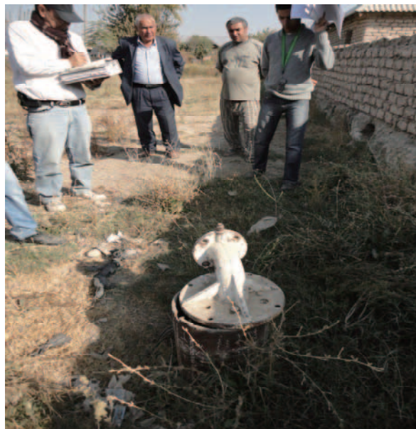
⑤kuitemiz村では、3本中2本は埋まっているため使用不能、1本はポンプが入っている状態である。
