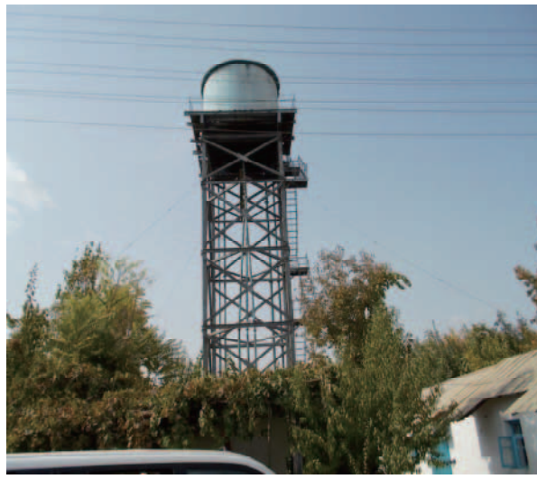
⑥老朽化が著しい、既存の高架タンク。
