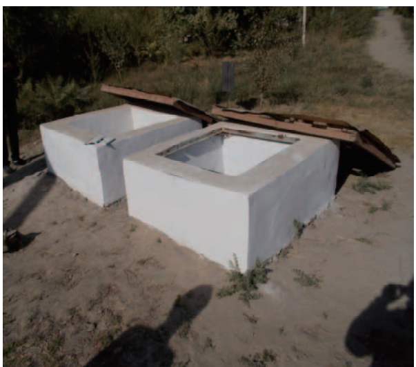
⑤No.1の井戸は、地下掘込み式井戸で、井戸深度が50mである。ポンプは2台設置可能であるが、1台のみ設置している。
