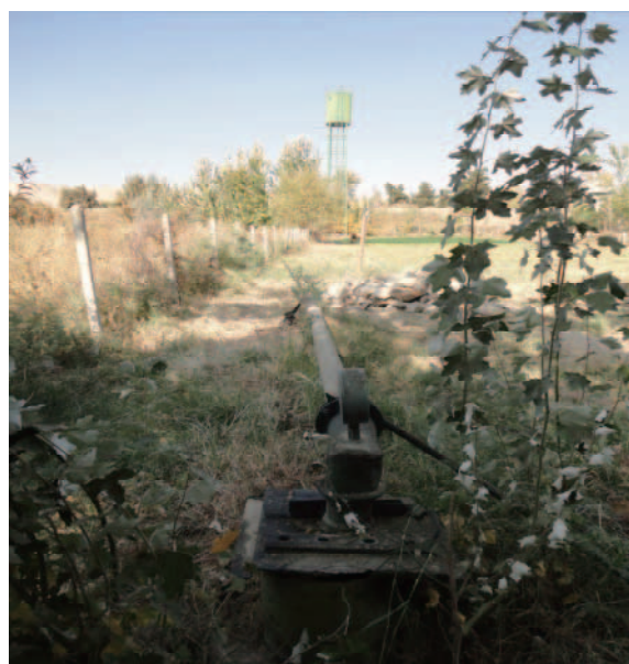
⑥Peshkadam2村の井戸はポンプが入った状態で休止している。既存タンクも使用されていない。
