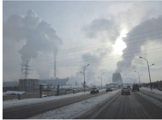
第3火力発電所 (2012年11月28日)
