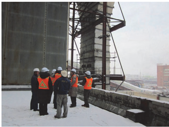
第4火力発電所排ガス測定現場 (2012年12月4日)
