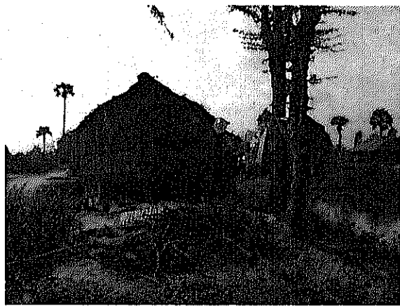
House on canal bank (MR-1, Sta. 0.7 km)
