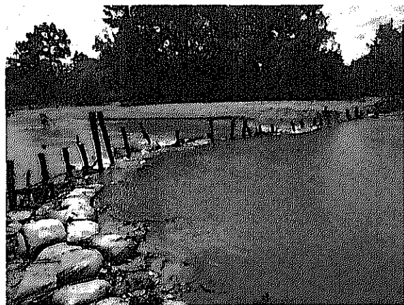
土嚢、材木等を利用した簡易取水施設
