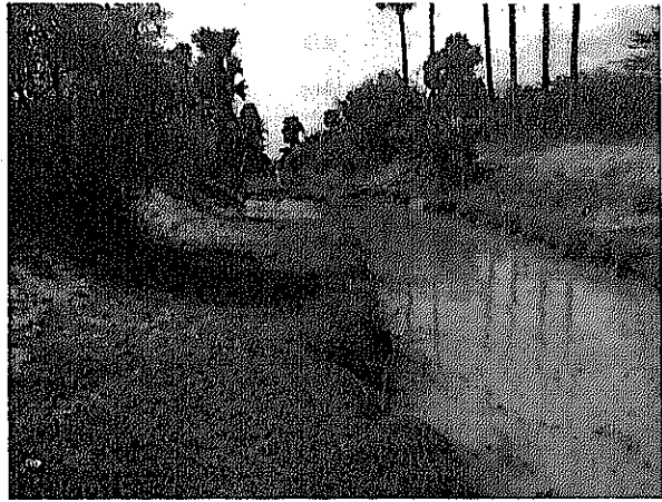
幹線用水路 35 (Khporb Krous 貯水池付近)
