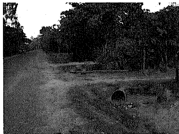
幹線用水路上のカルバート
