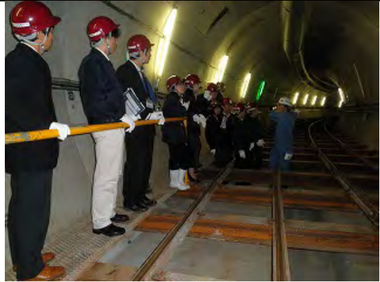
新羽末広幹線建設現場視察(10/21)
