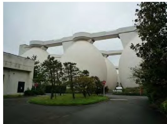
北部水再生・汚泥資源化センター視察 (10/5)
