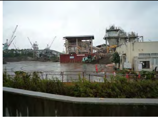
改良土センター視察 (10/5)
