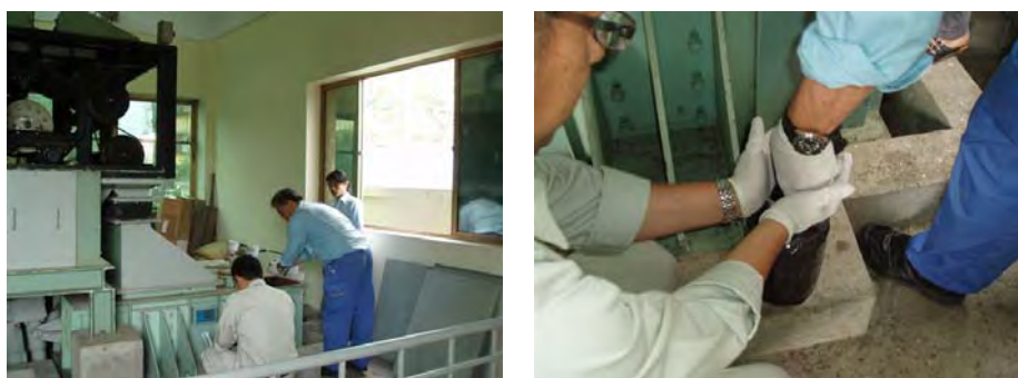
写真-B. 1. 4. 3 脱水汚泥採取状況（チュックバック下水処理場）（出典：JICA 調査団）
