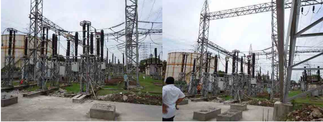
コンデンサ撤去後、新規コンデンサ用に基礎の打ち増しを実施
