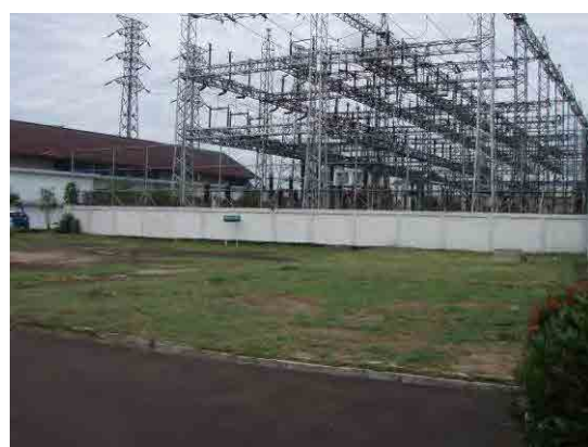
写真 スwitchヤードに隣接した空地
