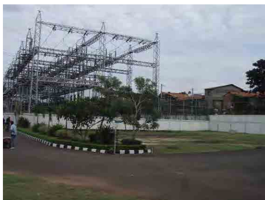
写真 スwitchヤードに隣接した空地
