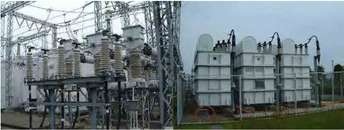
図 5.27 東京電力におけるケーブル構内連絡設計事例と隠蔽型機器設置
