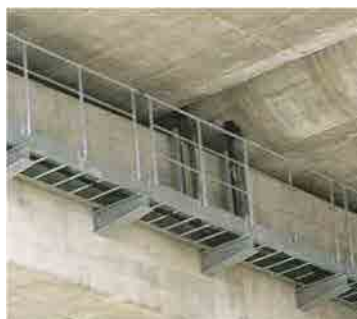
Exemple d'une passerelle d'inspection en acier
