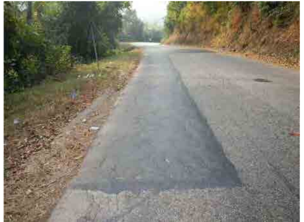
写真 2.2-1 カアカ橋のコヤ側の道路の補修跡
