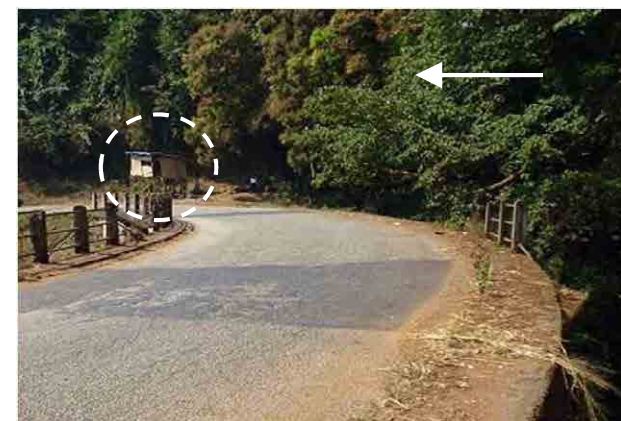
夜間見張り小屋の新設。対面できない停車中の車両が、夜間、武装強盗に襲われるのを防ぐために警察が見張り小屋を建てた。
