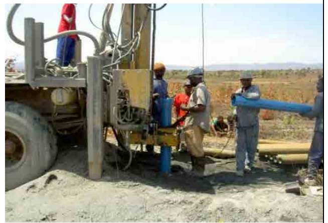
2. ケーシングの設置(口径 160mm) TTC No. 3
