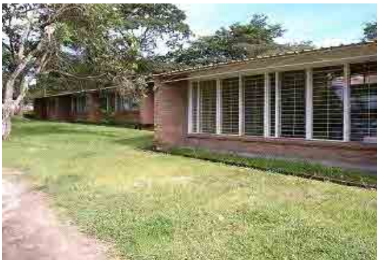
大学の講義室棟 平屋煉瓦組構造、窓開口部はガラスシャロシー形式
