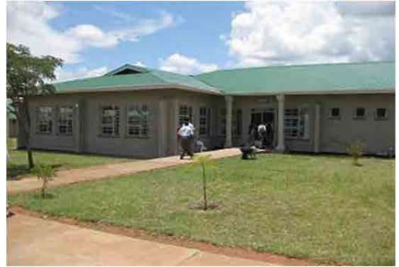
図書館棟 SSB(土・セメントブロック)組積造に塗装仕上げが施されている。
