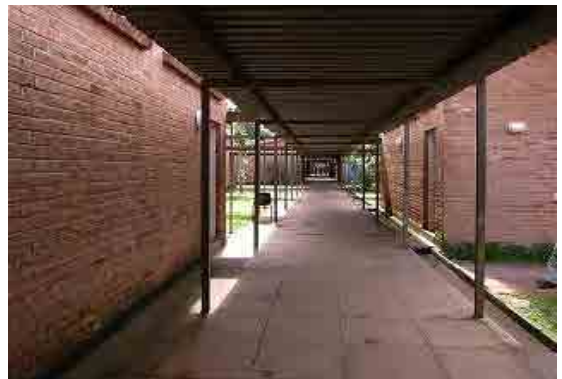
講義棟を結ぶ渡り廊下
