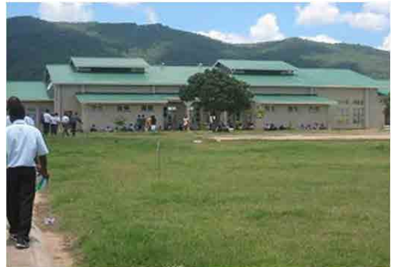
多目的ホール。鉄筋コンクリートに鉄骨屋根構造で、ホールに厨房が併設されている。
