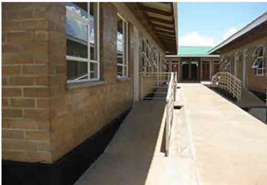
講義室棟 施設は全てSSB(土・セメントブロック)による組積造。窓建具は標準型スチール製サッシ
