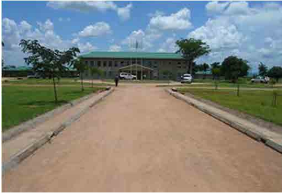
管理棟 管理棟のみが2階建てで他は全て平屋建てで建てられている。
