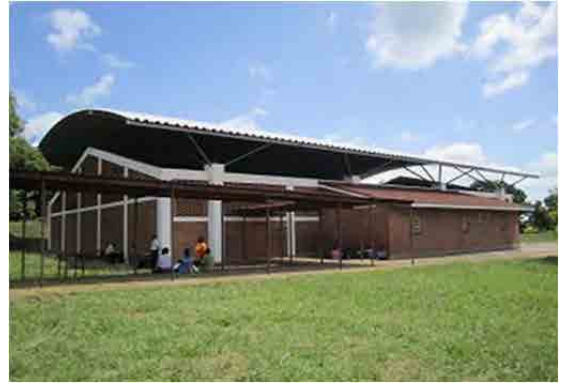
屋内体育館。平成 15 年度無償により教員養成校改善計画として整備された施設のひとつ。
