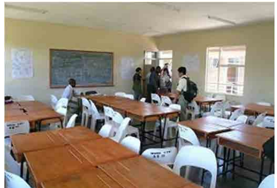
一般講義室(40人) 外壁はSSBの素地仕上げ、内壁はモルタル塗装仕上げ、モルタル床、天井は木合板塗装
