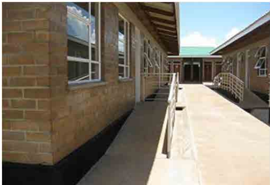
講義室棟 施設は全てSSB(土・セメントブロック)による組積造。窓建具は標準型スチール製サッシ
