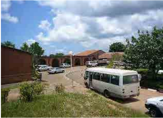
DCE 正面アプローチ。入口より構内道路は緩やかな下り傾斜で入って来る。
