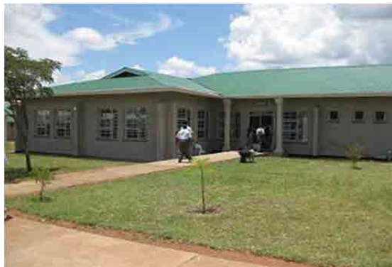
図書館棟 SSB(土・セメントブロック)組積造に塗装仕上げが施されている。
