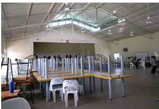
多目的ホール 日常は食堂として使用されている。床はタイル張り、ステージ背後に更衣室があり、地下倉庫を持つ。
