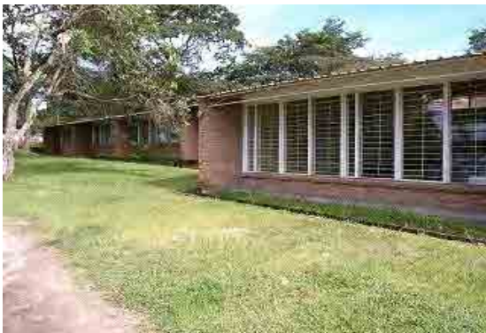
大学の講義室棟 平屋煉瓦組構造、窓開口部はガラスシャロジー形式
