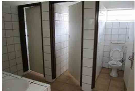
学生寮の洗面・トイレ・シャワー設備 温水設備は設けられていない。
