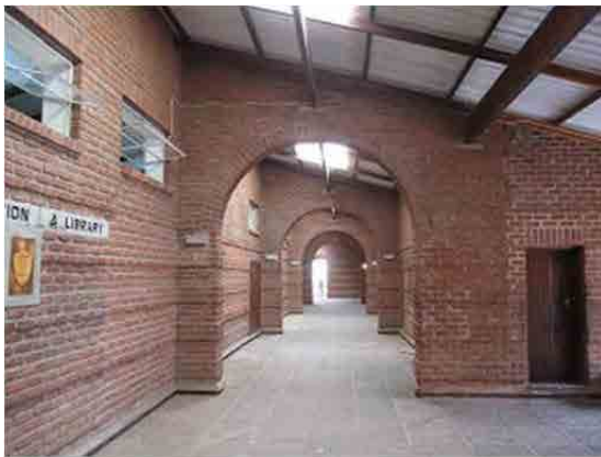
DCE 管理棟のエントランスホールと廊下。
