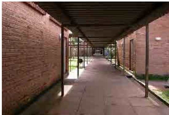
講義棟を結ぶ渡り廊下
