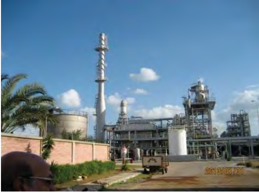
SIDPEC社エチレン製造プラント(30万トン/年) 東洋エンジニアリング(株)が建設(2001年完工)
