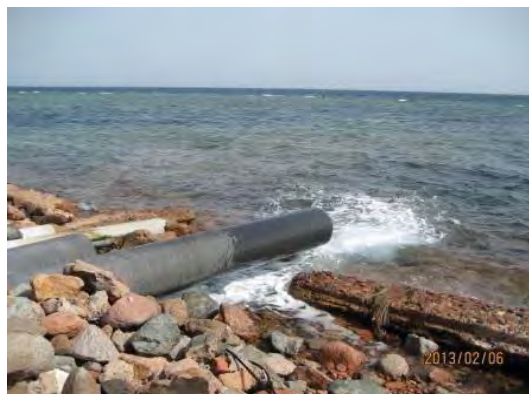
濃縮水放流(将来は沖合放流が義務付けられる)
