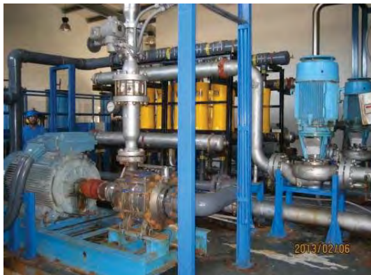
エネルギー回収装置(圧力直接変換方式)
