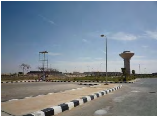
プラント全景(165,000m 3 /日)
