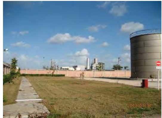
濾過水タンク(12,000m 3 /基x2基)
