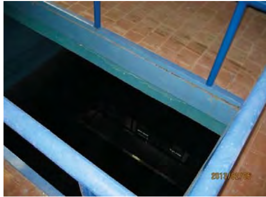
陸上部取水ピット
