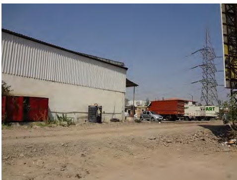
車両基地 写真 7:工場
