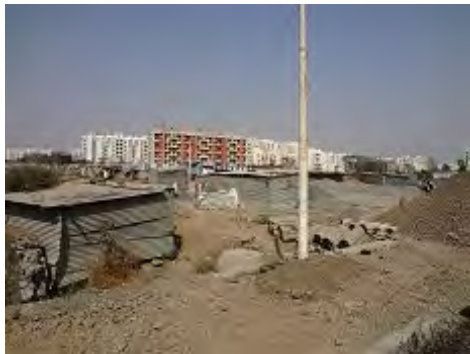
NH4 東側 写真 13: 建設に従事する労働者の住居
