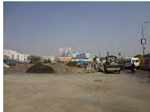
NH4 東側 写真 14: 工事中の土地
