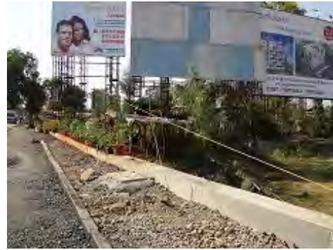
NH4 東側 写真 10: 空き地
