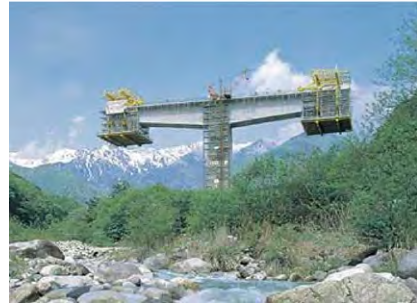
図 5.7.5 張出し架設工法のイメージ図
