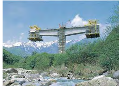
図 5.7.5 張出し架設工法のイメージ図
