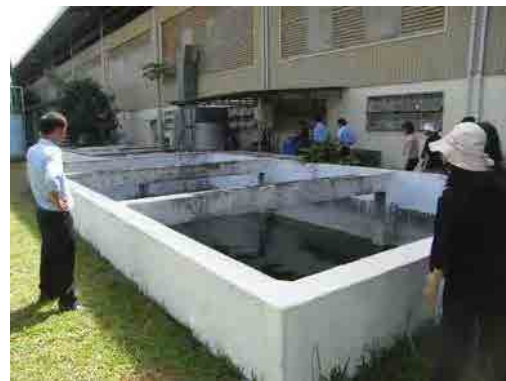
Hình 2.5-7 Kiểm tra bằng cách quan sát điều kiện vận hành của hệ thống XLNT
