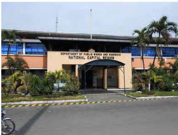
写真 - 11 : 排水ポンプ車の配置対象リージョンである NCR (National Capital Region) の DPWH オフィス。マニラ首都圏マニラ市マニラ港エリア、DPWH 本部オフィスの近隣に位置する。
