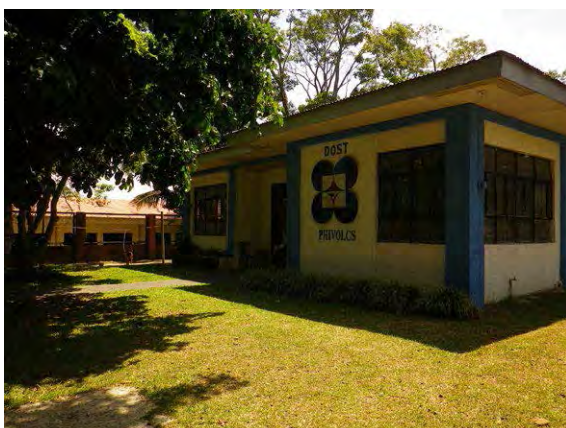
写真 - 3 : タガイタイ有人地震観測所 (強震計対象サイト)。強震計を更新し、衛星通信機材を設置することにより、波形データと震度情報のリアルタイムデータ伝送を実現する。
