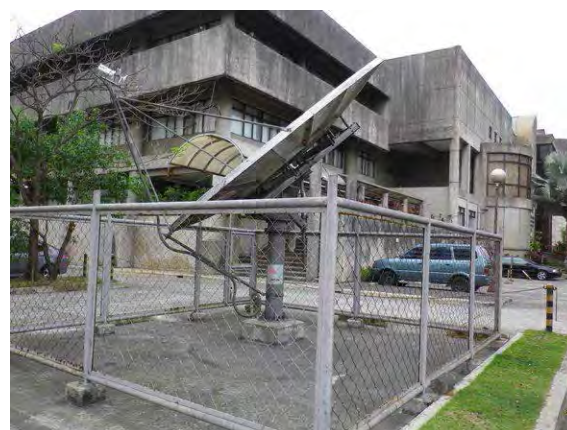
写真 - 2 : PHIVOLCS 本部棟と敷地内に設置された ABS 衛星通信用アンテナ (本プロジェクトでも利用する)。IP-Star 用アンテナは建物屋上に設置されている。本プロジェクトでは、IP-Star の冗長性を確保するため、IP-Star 用衛星通信機材を 1 セット調達する。
