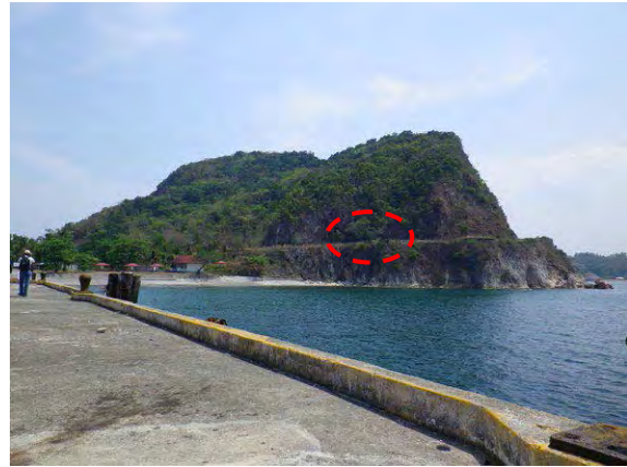
写真 - 8 : 同左。栈橋から津波データ伝送局設置予定場所を望む (距離 : 約 150m、高さ : 水面から約 15m)。
