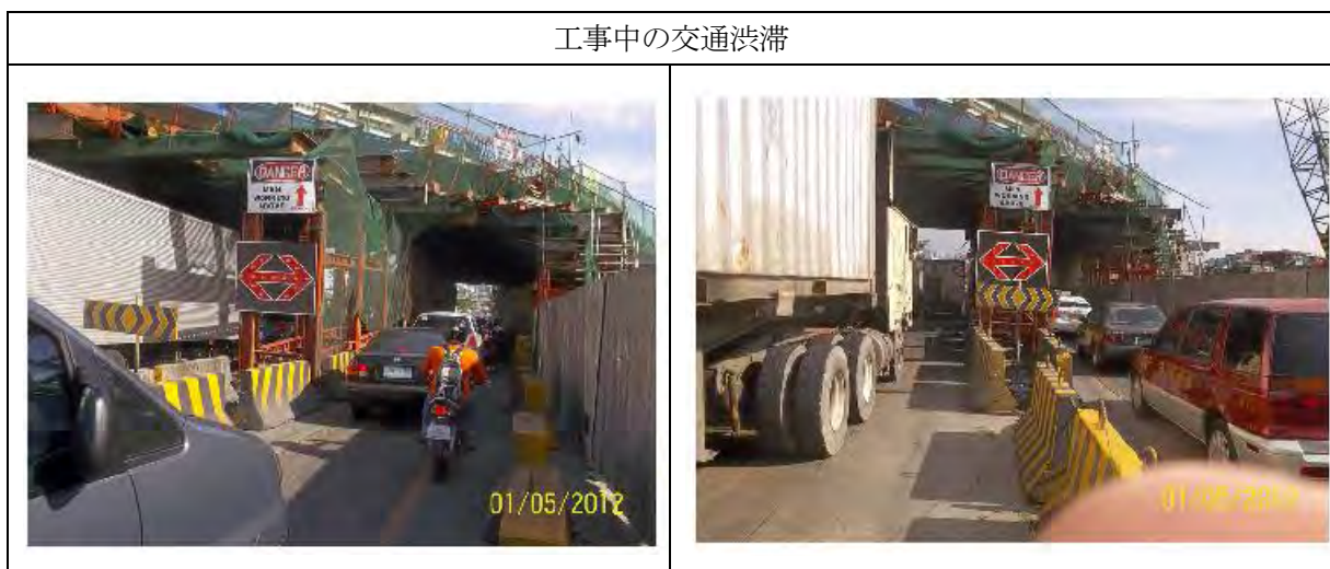
上記写真は、同様のプロジェクトの工事における中空床版の支保工・足場を示している。工事中は車線が現況の3車線から2車線に縮小され、激しい交通渋滞の原因となっている。
