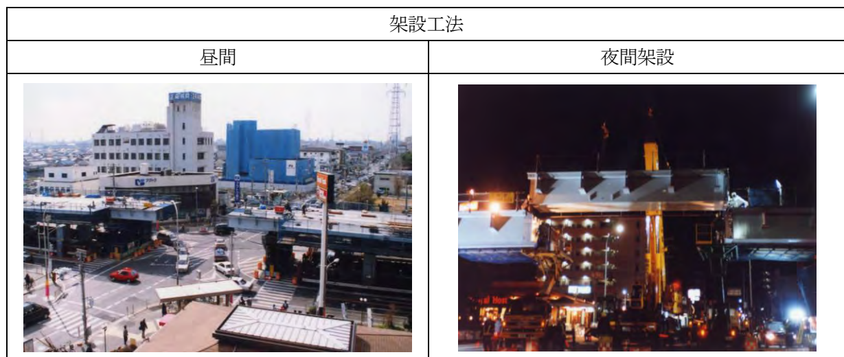
上記写真は交差点における昼間と夜間の架設状況を示すもので、架設期間は9日間である
