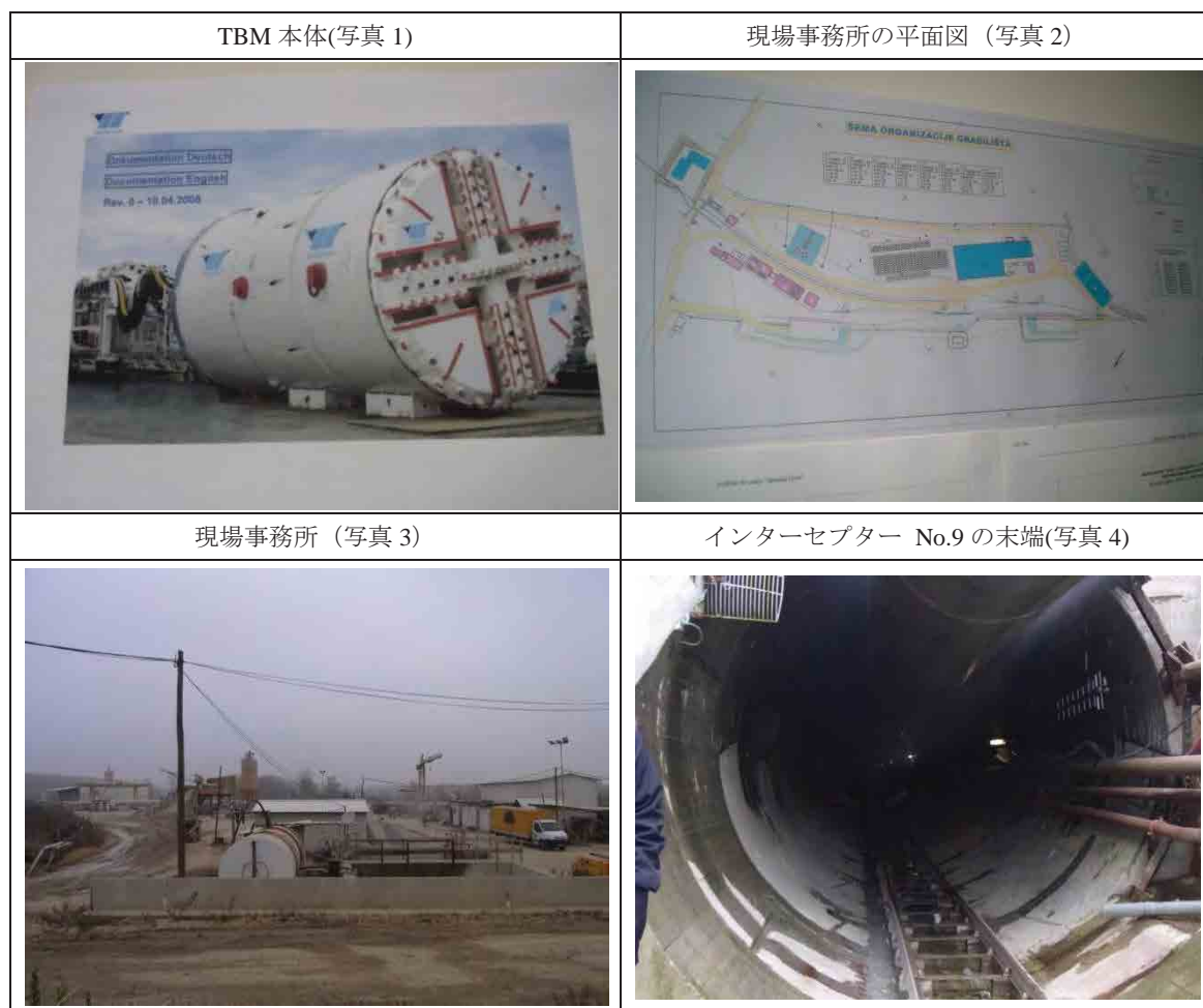
図 4.23 現場写真 (インターセプターNo.9)
