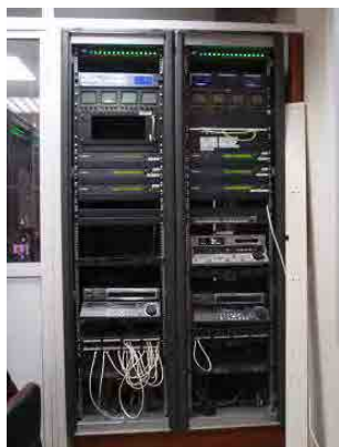
写真-7: MCR 内にある送出機器。左奥に送出番組用のサーバーが設置されている。
