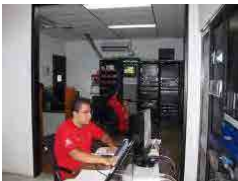
写真-9：主調整室の様子。レコーダー、プレーヤー及びサーバーなどを設置している。
