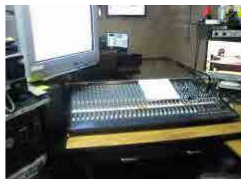
写真-8：音響調整室。ガラス越しに映像調整室の大型モニターを見ることが可能である。
