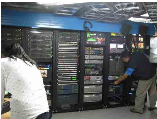
写真-9：主調整室。レコーダー、プレーヤー及びサーバーなどが設置されている。
