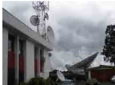
写真-2：中継車、送信所との放送信号通信用及び衛星との通信用の送受信機。
