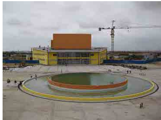
写真-10: カママ地区に建設中の新局舎。建物・機材とも中国政府からの融資。2013年3月完工予定。
