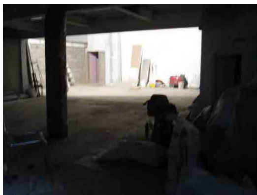
写真-5：ハイビジョン（HD）画質撮影用スタジオを新規建設中。
