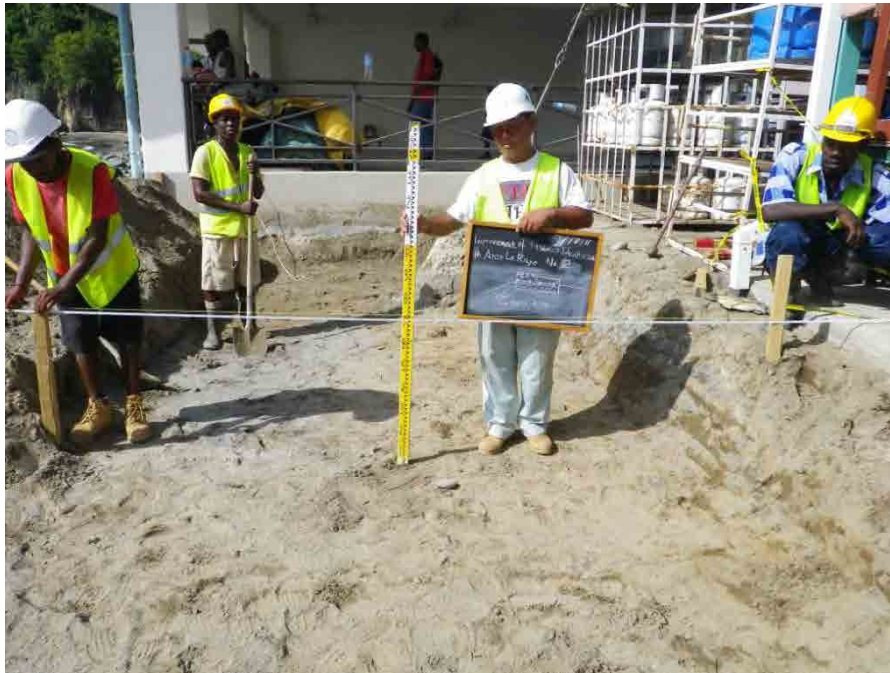
No. 2 付近掘削完了
