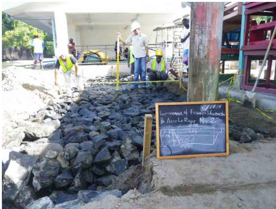
No. 2 付近碎石敷均し
