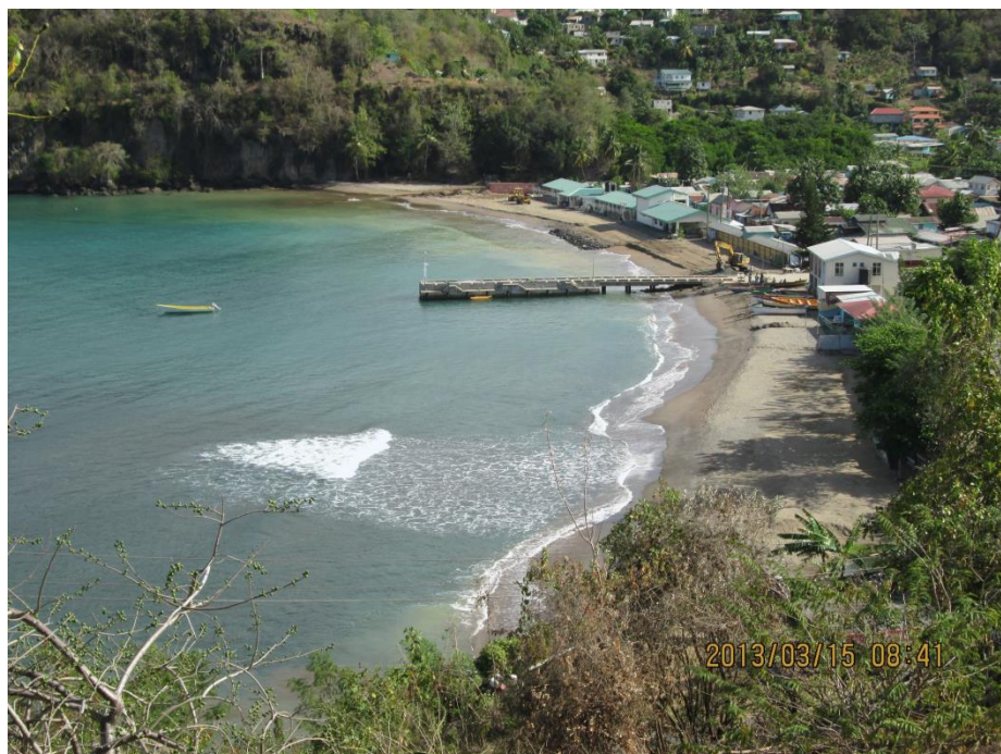
写真 5-3-2-6 完工時の全景（南側海浜）
