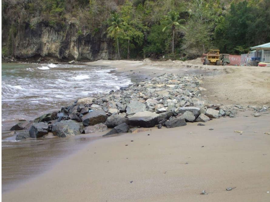
写真 5-3-2-3 漁具倉庫前浜の完工状況 (2)
