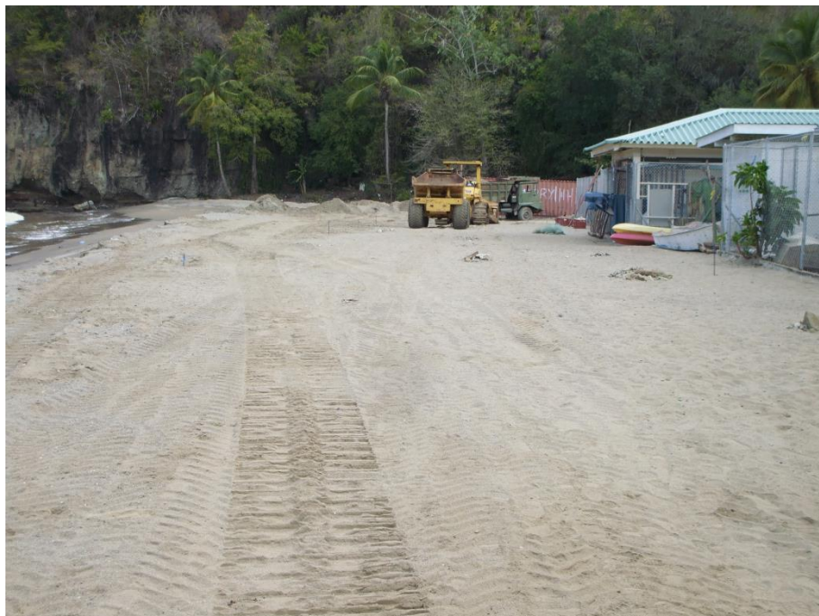
写真 5-3-2-1 漁具倉庫前浜の完工状況
