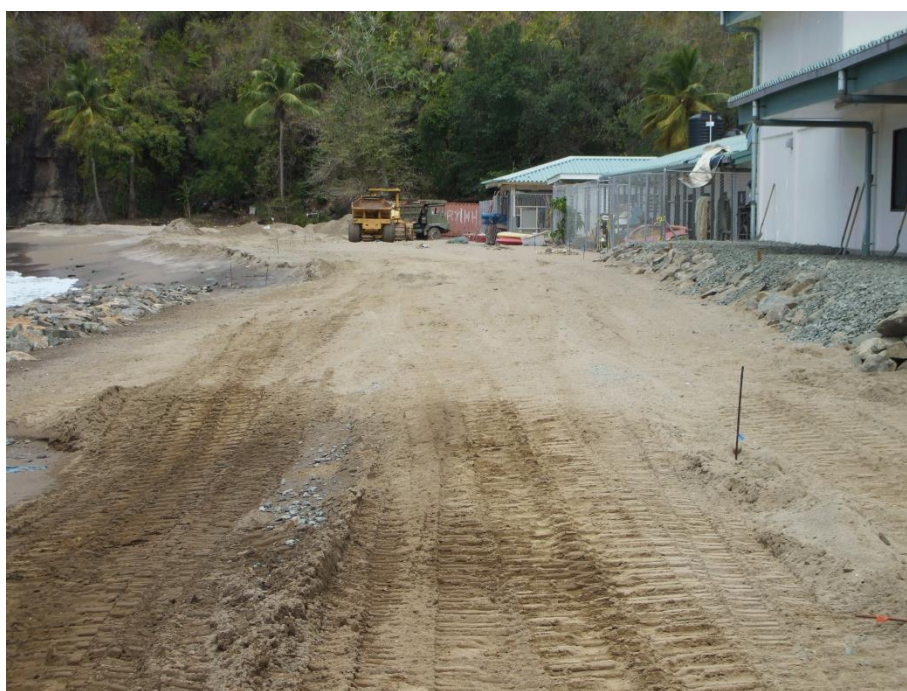
写真 5-3-2-2 水産複合棟前浜の完工状況 (1)
