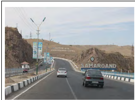
都市間道路状況
