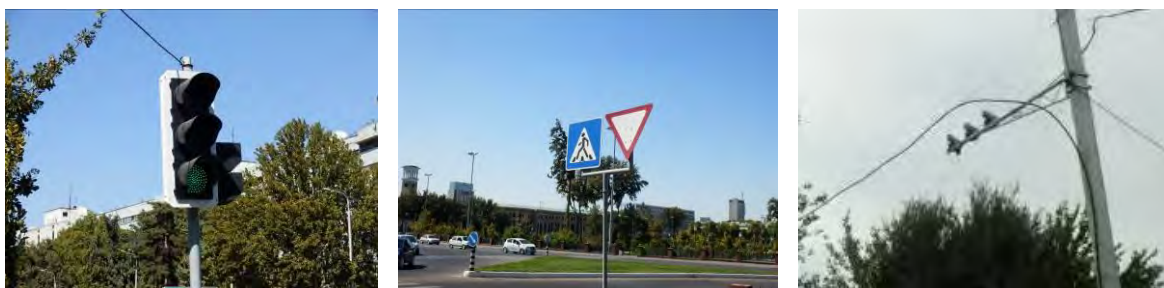
図 8-8 国道付帯設備（出典:調査団現地調査結果）
