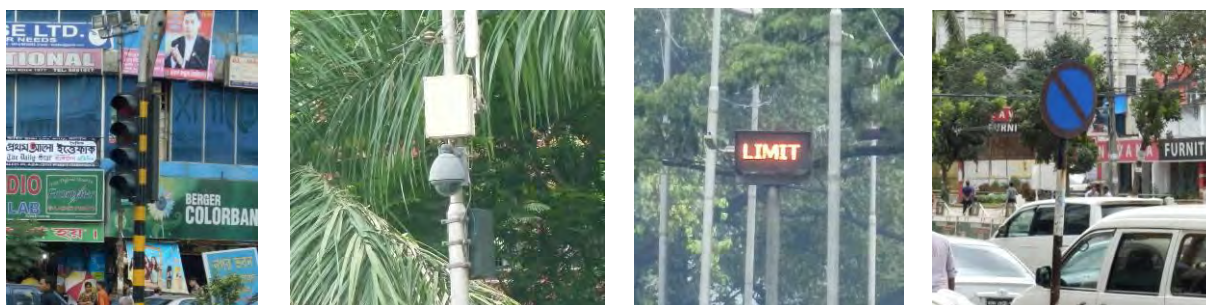
図 7-18 国道付帯設備 (出典:調査団現地調査結果)
