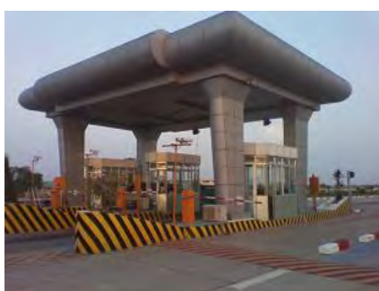
CCTV 及び料金徴収所
