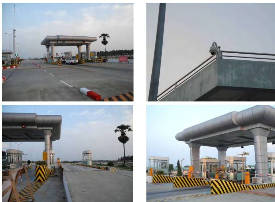
図 5-11 国道・高速道路付帯設備 (出典:調査団現地調査結果)
