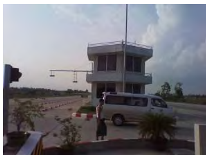
ETC アンテナ及び事務所
