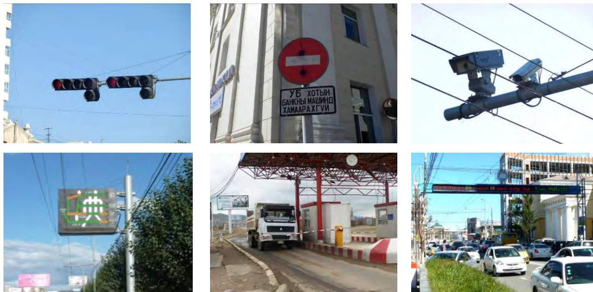
図 6-12 国道付帯設備 (出典:調査団現地調査結果)
