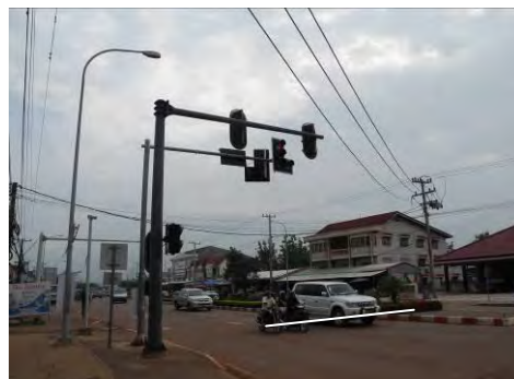
停止線の直上に信号が取り付けされており、また、交差点を挟んだ向かい側(直進流出)に信号がなく(左下写真参照)、先頭車両は信号が見えない。
