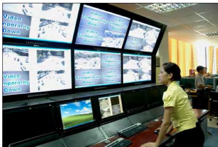
図 2-84 ハノイにおける交通管制センター (出典:Tran_Vu_Tuan_Phan ITS in Vietnam)
