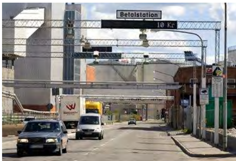
図 2-21 ガントリー上に設けられたレーザースキャナーと CCTV カメラ
