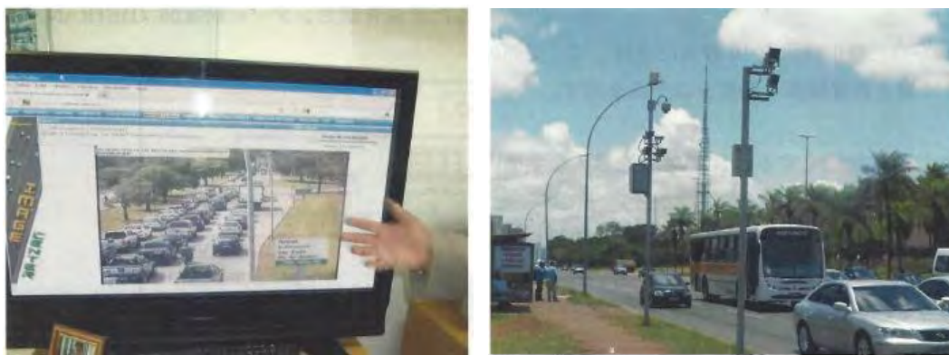
図 1-21 静止画像撮影送信システム(左)、信号交差点:CCTV、OCR(右) (出典：ブラジル国 ITS マスタープラン詳細計画策定調査報告書 (JICA) )
