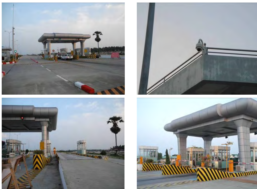
図 4-1 国道・高速道路付帯設備 (出典:調査団現地調査結果)
