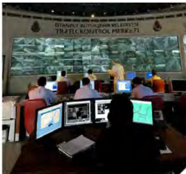
図 1-16 イスタンブールの交通管制センター
