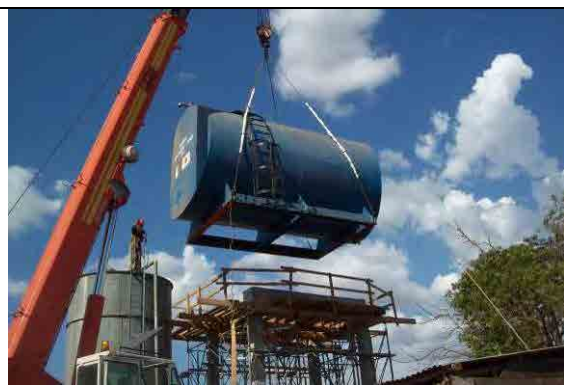
Befandriana 給水施設改修 (3年次)
