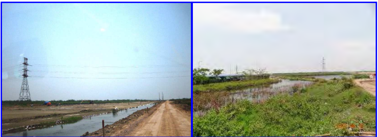
写真：Ha Noi –Hai Phong Highway の建設進行状況
