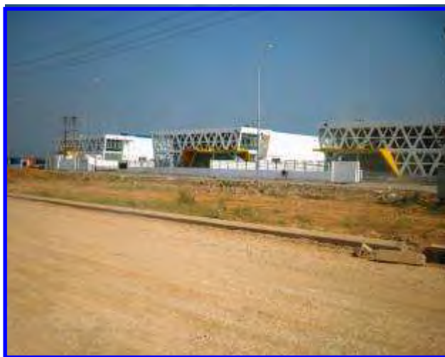
写真：VSIP 敷地内のレンタル工場の外観
