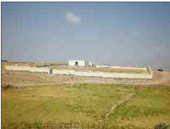
بشپړ شوی پروژه (S-FA01)
