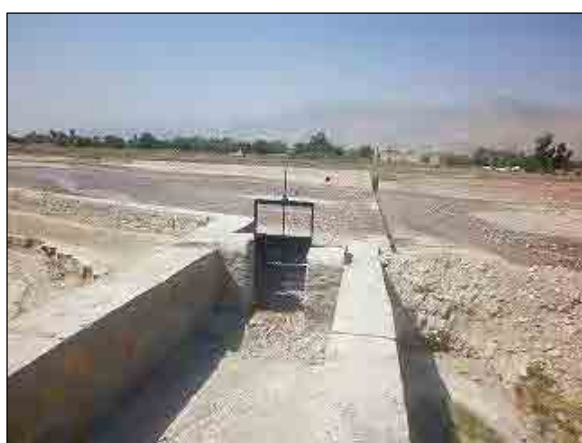
بشپړ شوي پروژه (S-SPU15)
