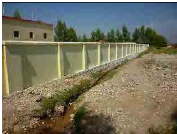
بشپړ شوی پروژه (B-SR01)
