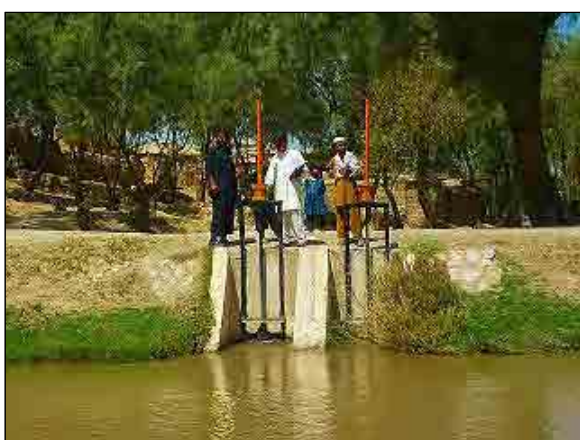
بشپړشوي پروژه (B-SR12)
