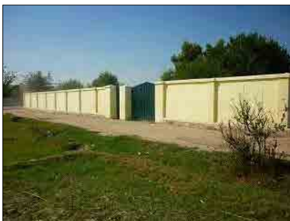
بشپړ شوی پروژه (B-SR02)
