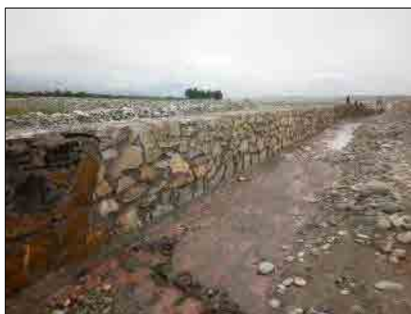
بشپړ شوي پروژه (S-SPU15)
