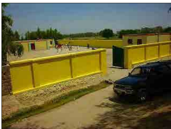
بشپړ شوی پروژه (B-SR01)
