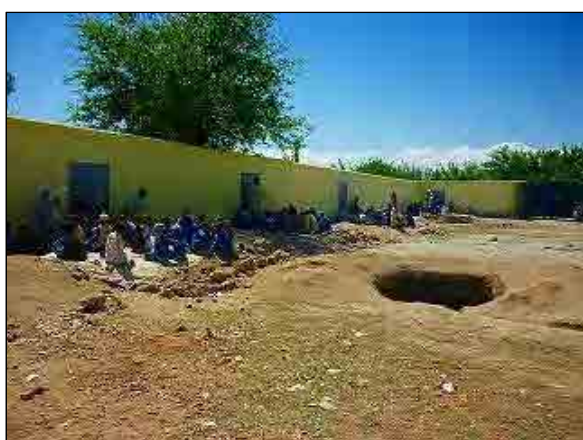
بشپړ شوی پروژه (B-SR02)
