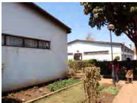
母子保健棟と産科病棟
