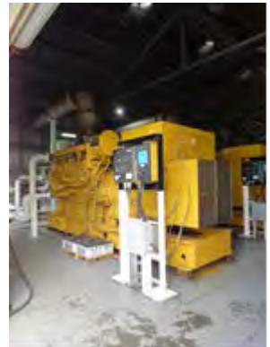
ポプア発電所のディーゼル発電設備
