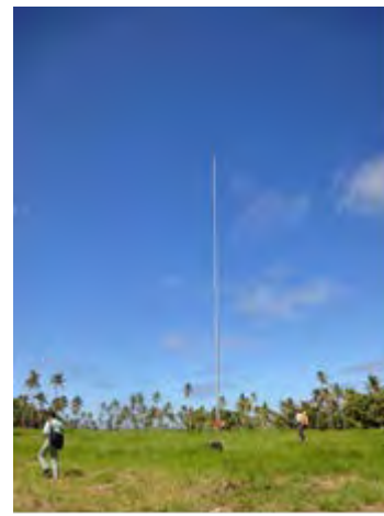
風況データ収集設備
