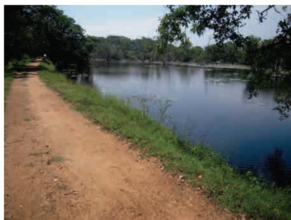
マドゥー郡ウイラッティクラム村の完成した灌 漑用溜池
