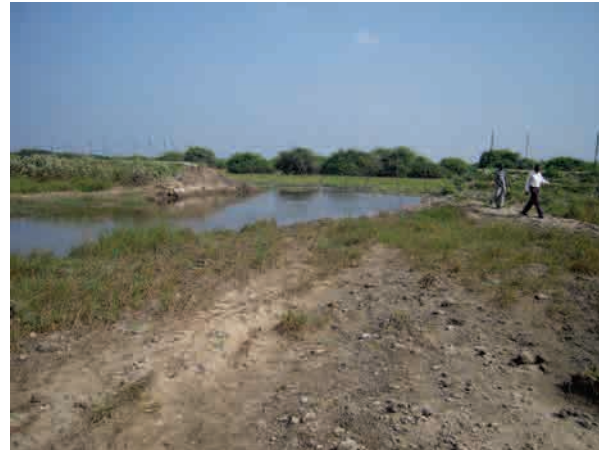
マンタイ西部郡テータラディ村の村内道路の被害の原因となった、洪水で破壊された溜池堤防
