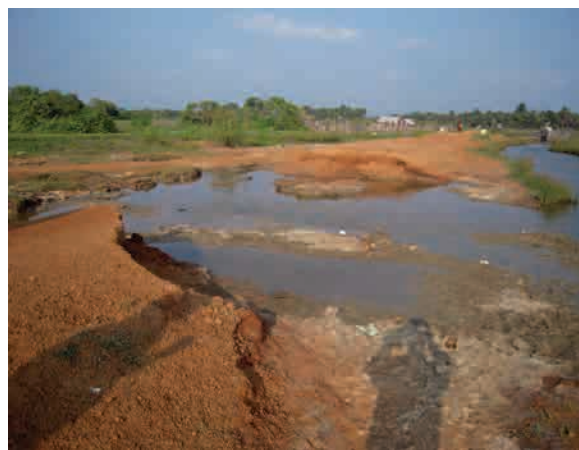
洪水で流されたマンタイ西部郡プトゥッカードゥ村の村内道路
