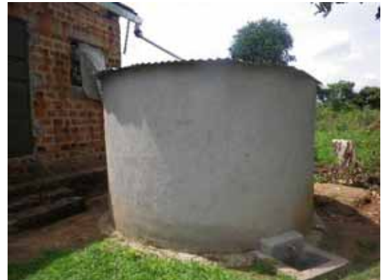
家庭・灌漑両用雨水採取タンク (ウガンダCEP対象地)
